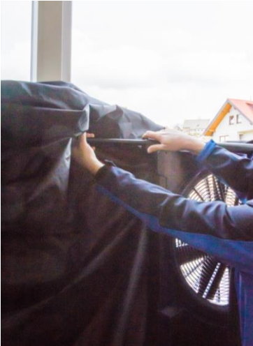
Abb. 16: Ventilatoreinheit wird mit Teleskopstange in Fenster eingespannt
